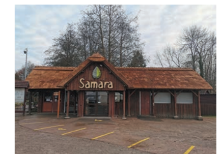
› Nouvelles toitures : bureaux, billetterie, bâtiment de l'aire des berges (CD80).
